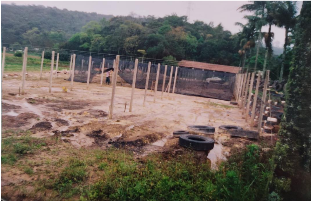
Figura 1 - Construção de telado para o desenvolvimento de mudas
