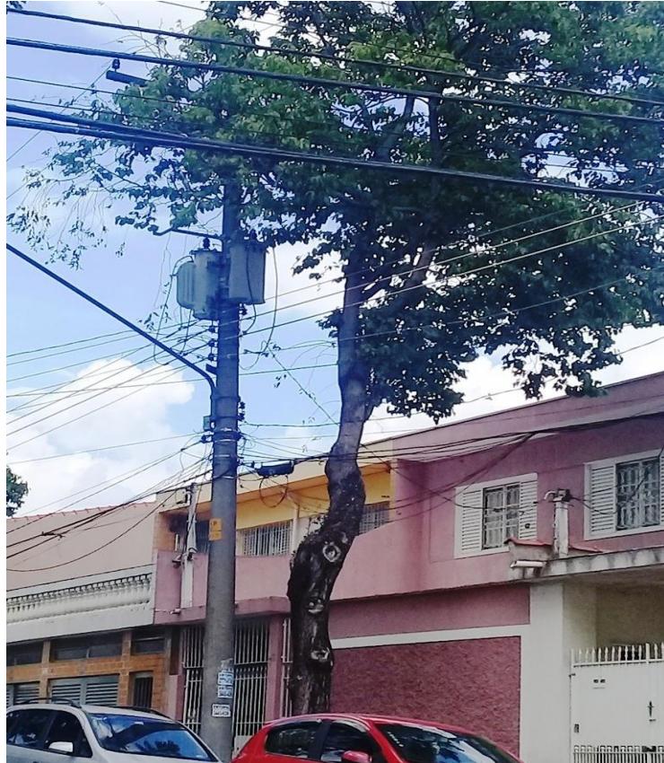
Figura 46 - Conflito de Ligustro ( Ligustrum lucidum W.T. Aito) com transformador
