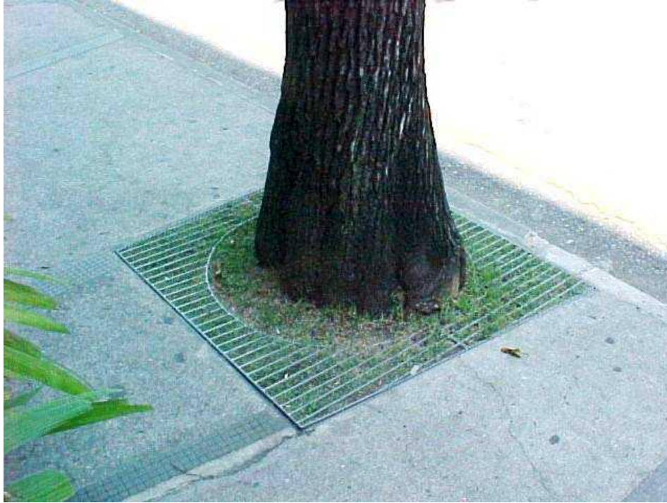
Figura 52 - Exemplo de grelhas arvoreiras
