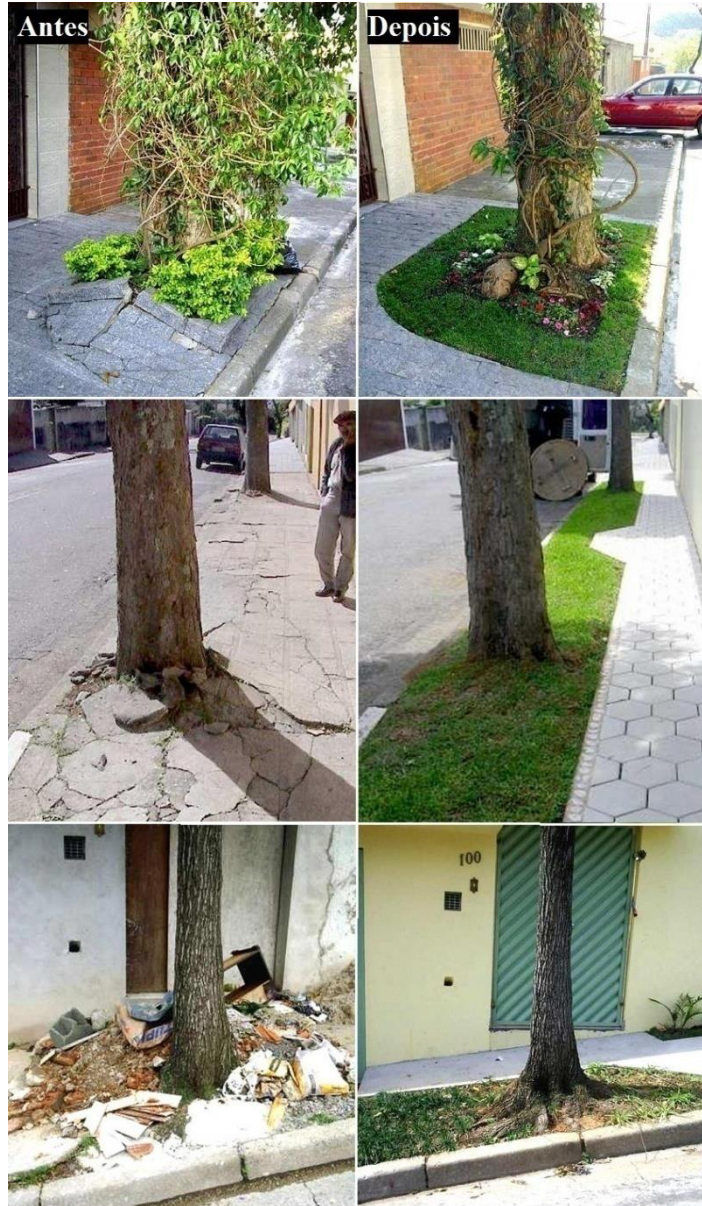
Figura 54 - Exemplos efetivos de ampliação de canteiros permeáveis
