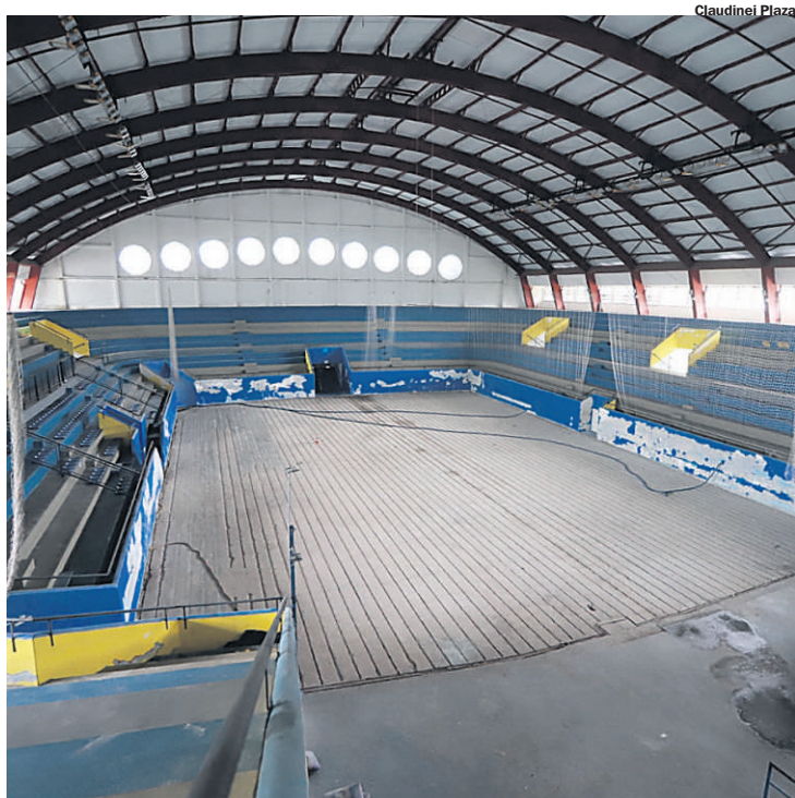
REFORMA. Ginásio receberá serviços de manutenção e conservação
