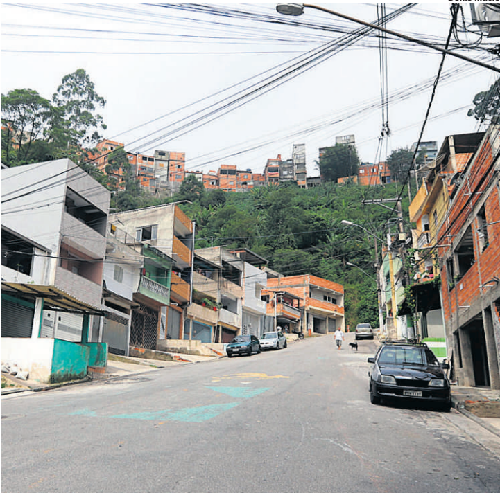
PERIGO. Rua da Bica, na Vila São Pedro, está entre locais de risco
